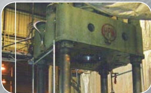
Alésage d'une portée de piston de 48 po de diamètre sur une presse de tuyau 3 000 tonnes
