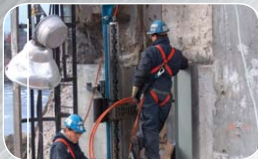
Fraisage de portées de roulement d'une porte de barrage hydroélectrique
