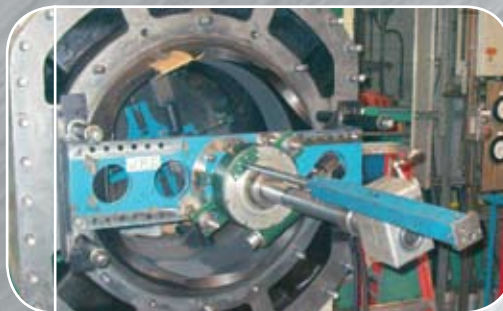
Alésage d'une portée de piston de 30 po sur un compresseur industriel
