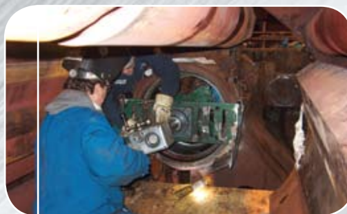
Alésage d'une portée de 24 po de diamètre dans un endroit difficile d'accès
