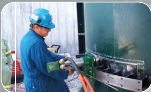
Fraisage sur un réservoir pour pratiquer une ouverture sans coupe
