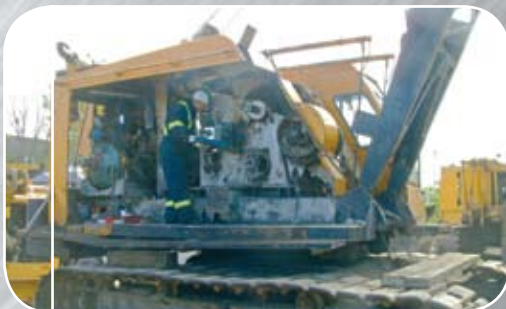
Alésage des portées de coussinets d'engrenages sur le châssis de grue
