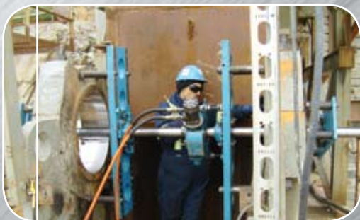
Alésage de portées d'axe sur le châssis d'un concasseur Hewitt - Robins
